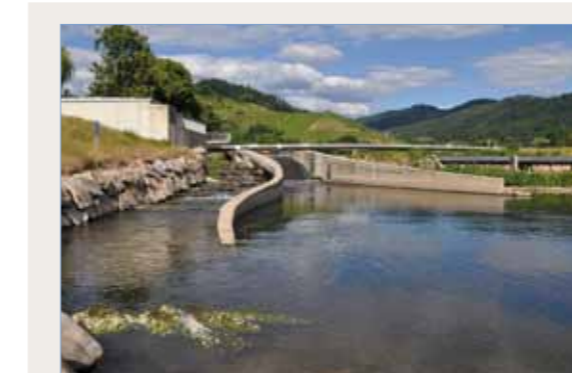
Wasserkraftwerk mit Fischtreppe in Gengenbach
